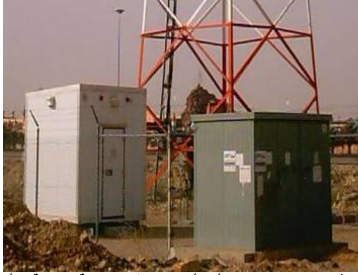
شكل رقم (3) صورة توضح أحد أنواع محطات التقوية الملحقة بالأبراج
